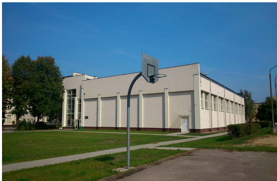
Nowa hala sportowa przy I Liceum Ogólnokształcącym w Brodnicy
